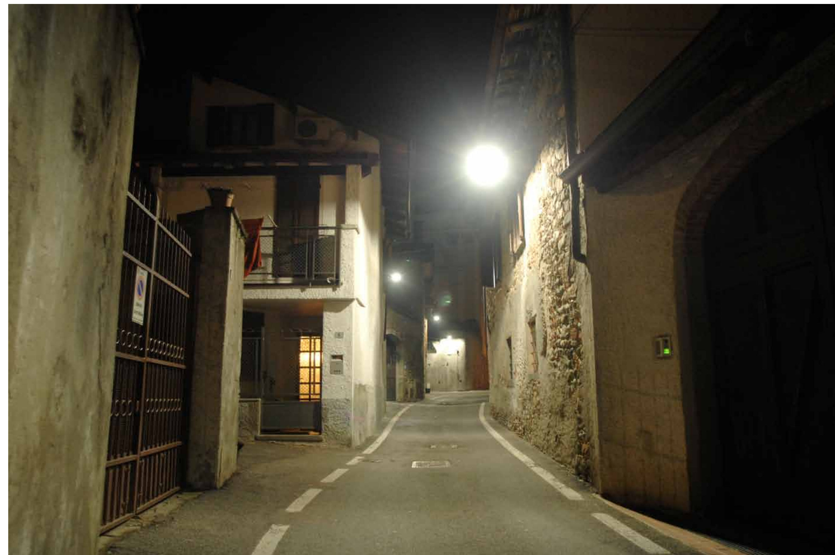
SOPRA STRETTOIA DI VIA MARTIRI DELLA LIBERTA' AD INTERVENTO REALIZZATO Corpo illuminante a Tecnologia Led modello Neri SN 104 con 40 LED (50W)
