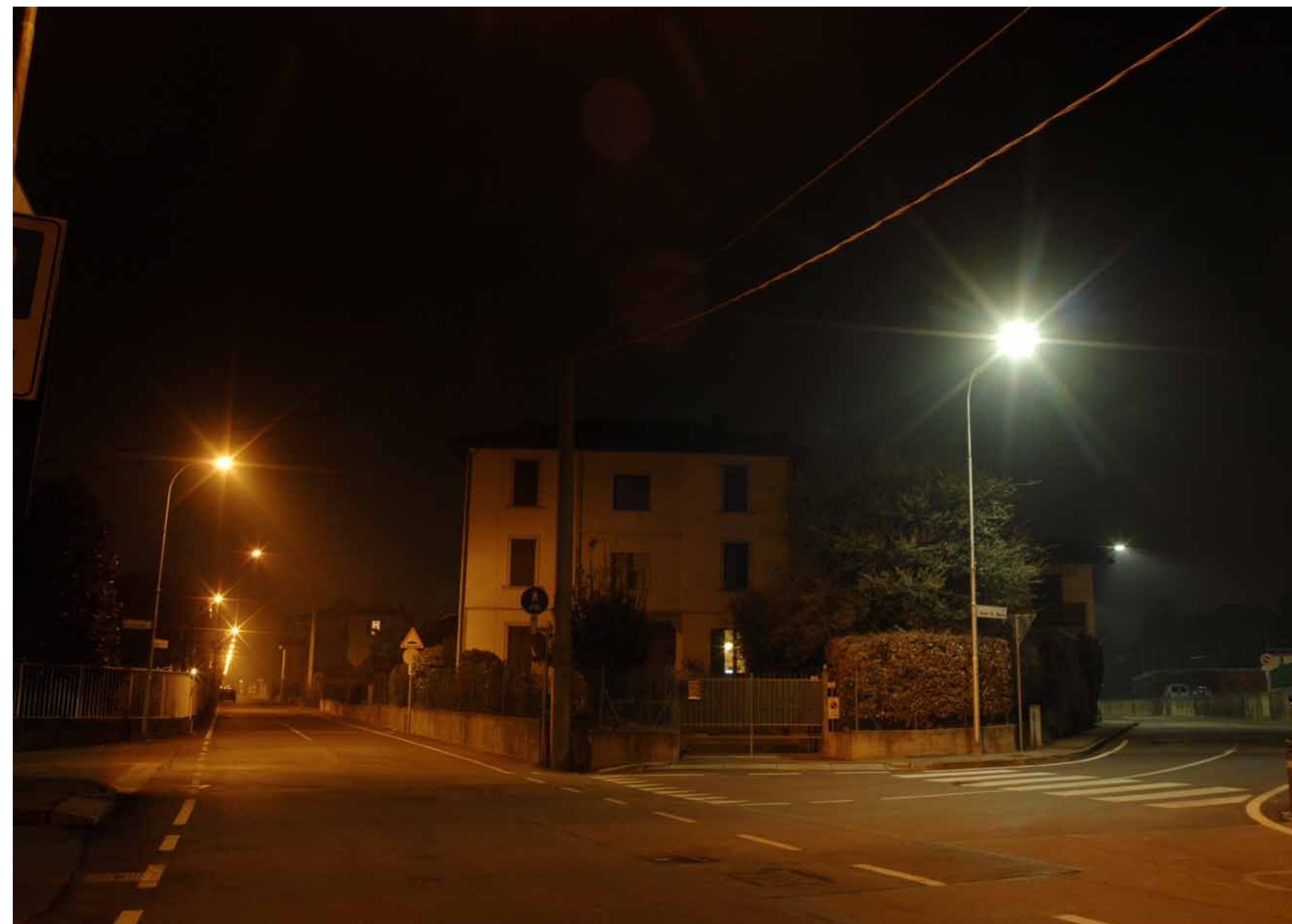
SOTTO INTERSEZIONE TRA VIA ROMA E VIA DON GIACINTO BANI PRIMA DELL'INTERVENTO
