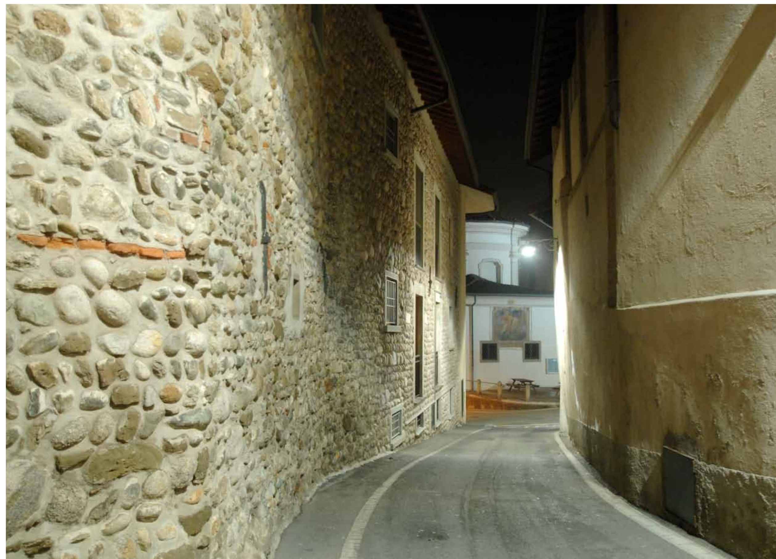
SOPRA VIA CESARE BATTISTI VERSO LA CHIESA PARROCCHIALE AD INTERVENTO REALIZZATO Corpo illuminante a Tecnologia Led modello Neri SN 104 con 40 LED (50W)
