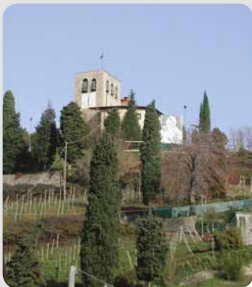
SOTTO IL MONTE GIOVANNI XXIII Torre sul colle S. Giovanni
