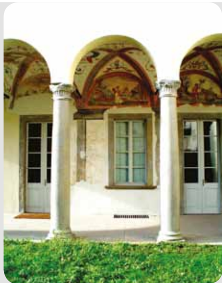
PRESEZZO Palazzo Furietti Carrara La loggia porticata Affresco del Cavagna com'è oggi e foto del 1942
